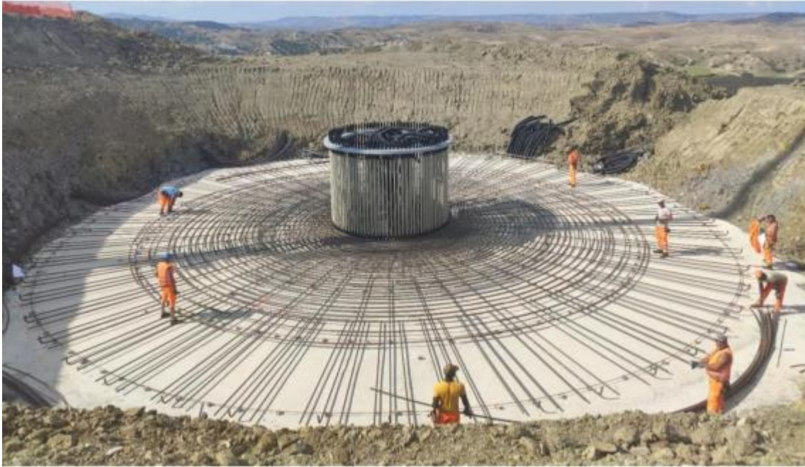
Figura 8 - Posa anchor cages tipo
