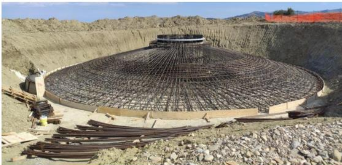
Figura 9 - Armatura plinto tipo
