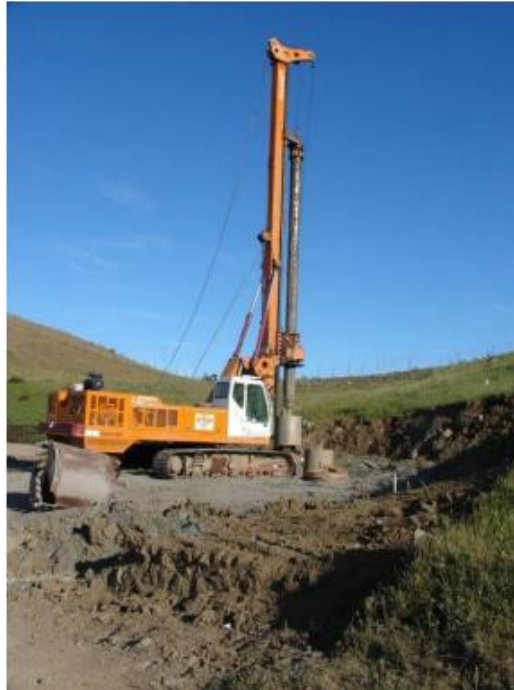
Figura 14 - Esecuzione dei pali di fondazione di un aerogeneratore
