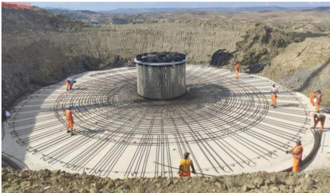
Figura 8 - Posa anchor cages tipo
