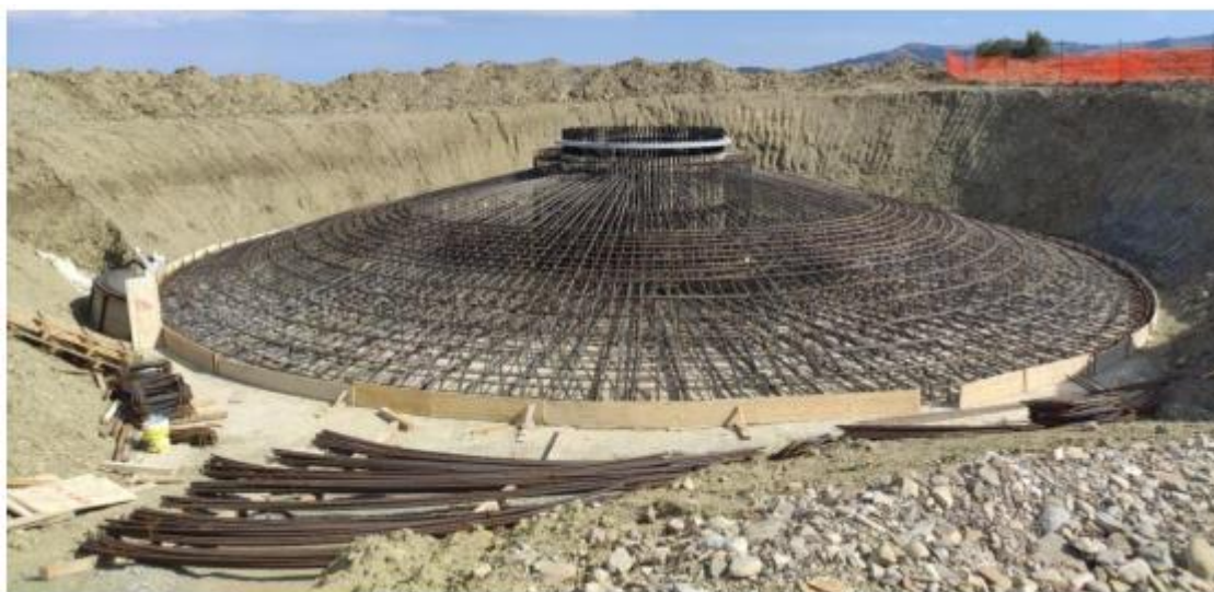
Figura 9 - Armatura plinto tipo
