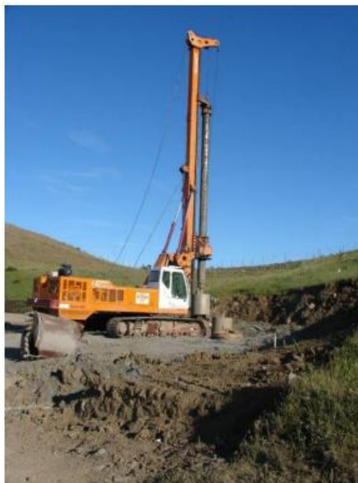
Figura 13 - Esecuzione dei pali di fondazione di un aerogeneratore
