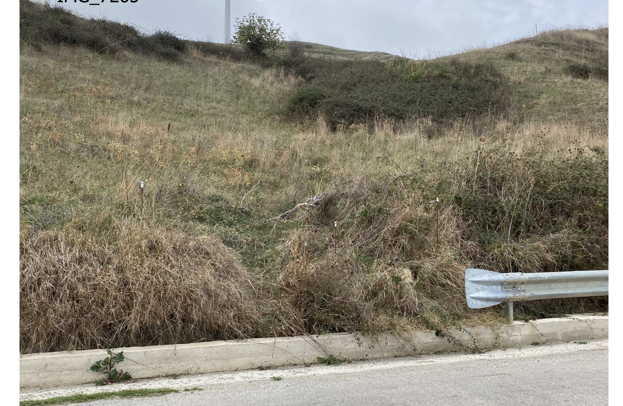
IMG_7265_Dal punto di ripresa fotografico Bene Isolato - Caltavuturo
