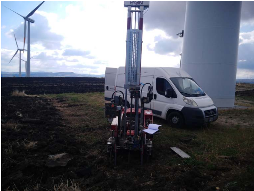
Prova penetrometrica statica CPT 01
