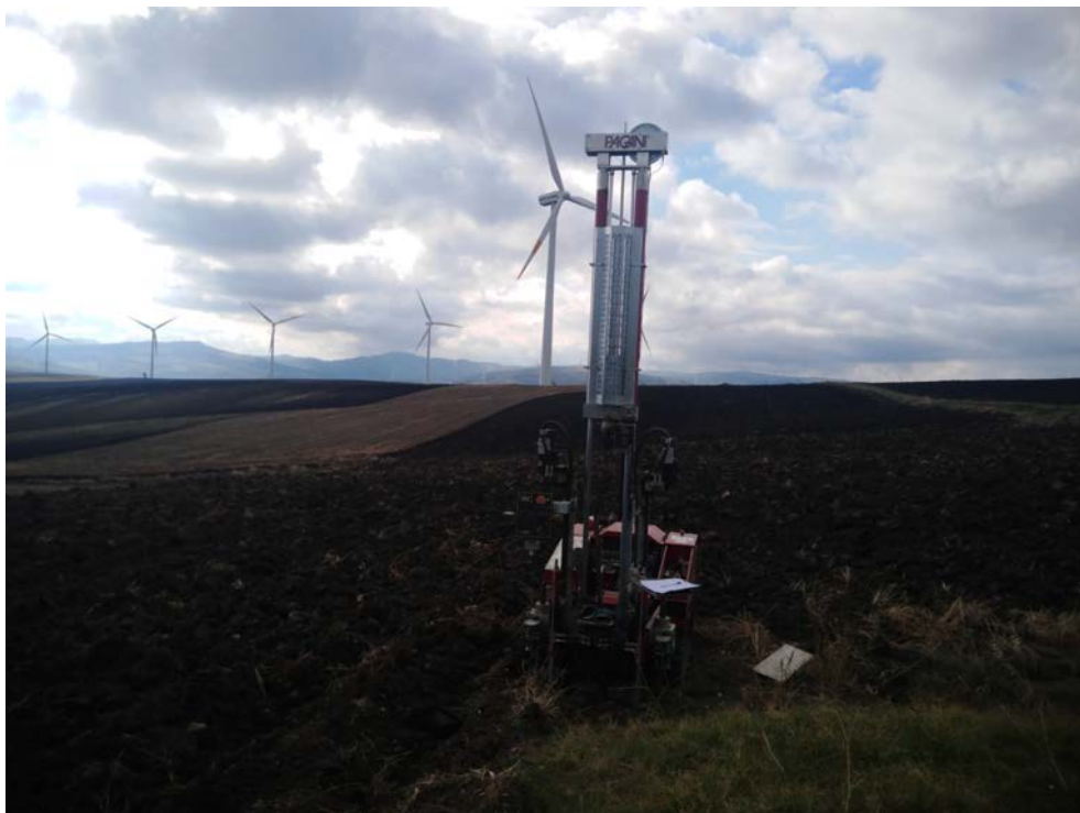
Prova penetrometrica statica CPT 02
