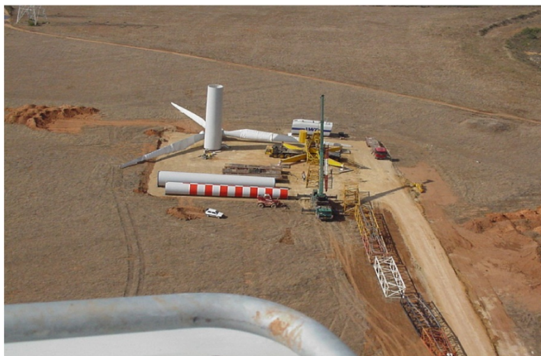
Figura 5 – Piazzola per il montaggio dell'aerogeneratore
