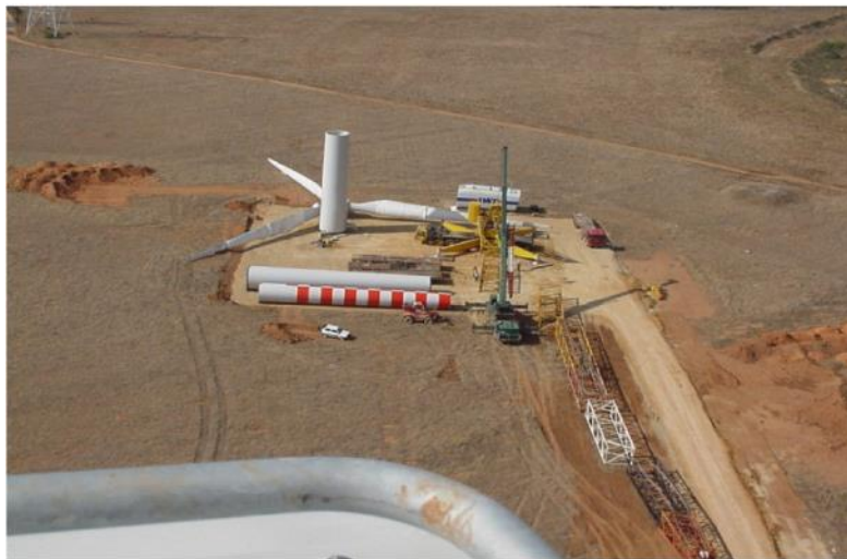
Figura 22 – Piazzola per il montaggio dell'aerogeneratore
