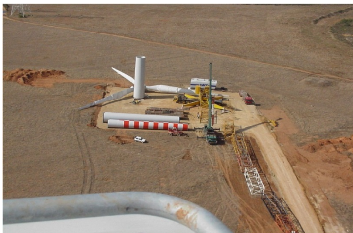
Figura 32 – Piazzola per il montaggio dell'aerogeneratore
