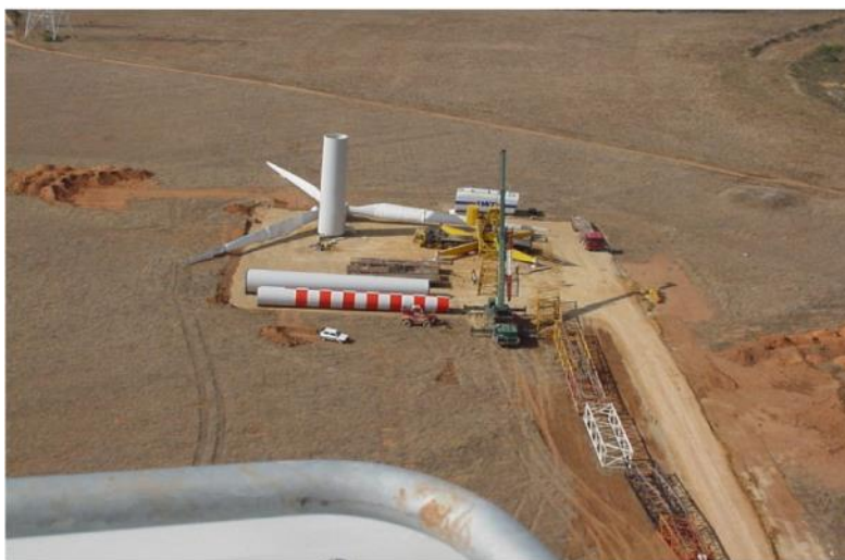
Figura 4 – Piazzola per il montaggio dell'aerogeneratore
