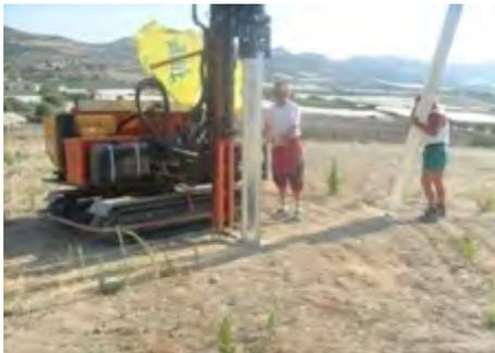
la struttura porta moduli sarà ancorata al suolo tramite pali in acciaio zincati a caldo (per resistere alla corrosione per tutta la durata del progetto) a sezione omega; i pali saranno direttamente battuti nel terreno ad una profondità media di 1,30 mt con apposita macchina battipalo senza uso di materiale di ancoraggio,
