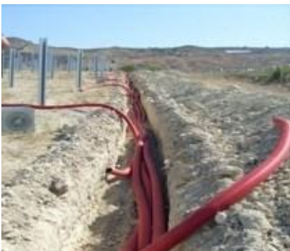
Figura 5: Tipo Cavidotto interrato
