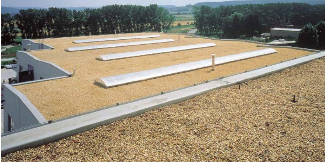
Figura 13- esempio copertura piana drenante in ghiaio lavato
