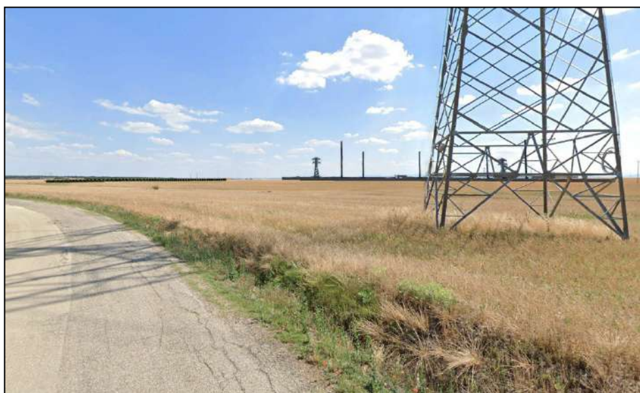
Figura 4-19: Vista dell'impianto e della Sottostazione Utente
