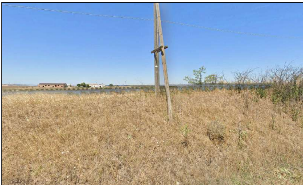
Figura 4-18: Vista dell'impianto da sud
