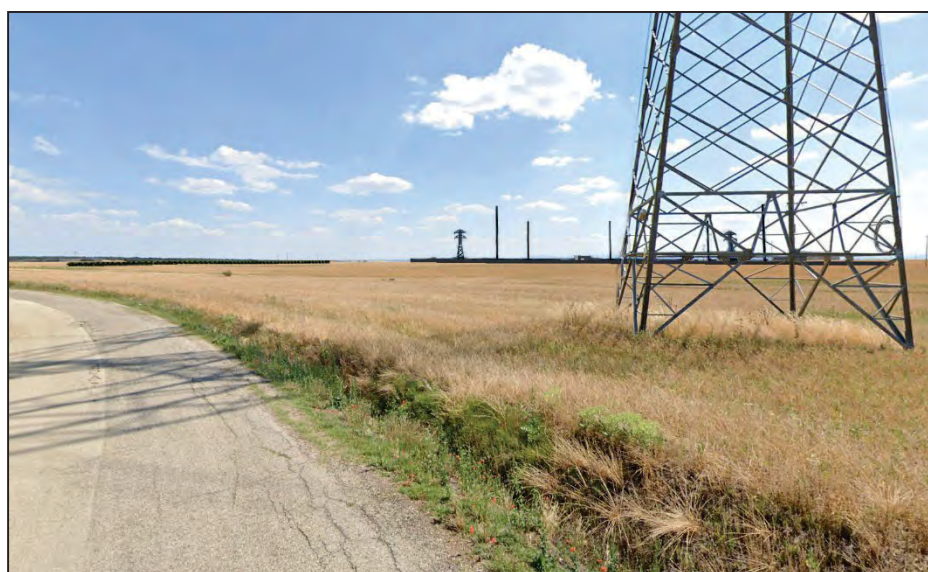
Figura 3-19: Vista dell'impianto e della Sottostazione Utente
