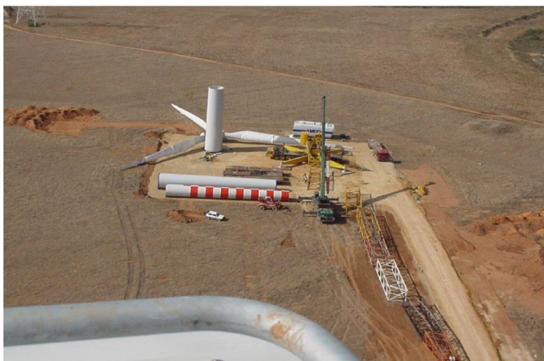
Figura 2 – Piazzola per il montaggio dell'aerogeneratore
