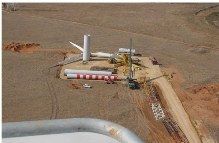
Figura 3 – Piazzola per il montaggio dell'aerogeneratore
