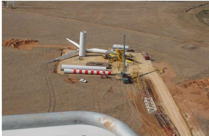
Figura 1 – Piazzola per il montaggio dell'aerogeneratore
