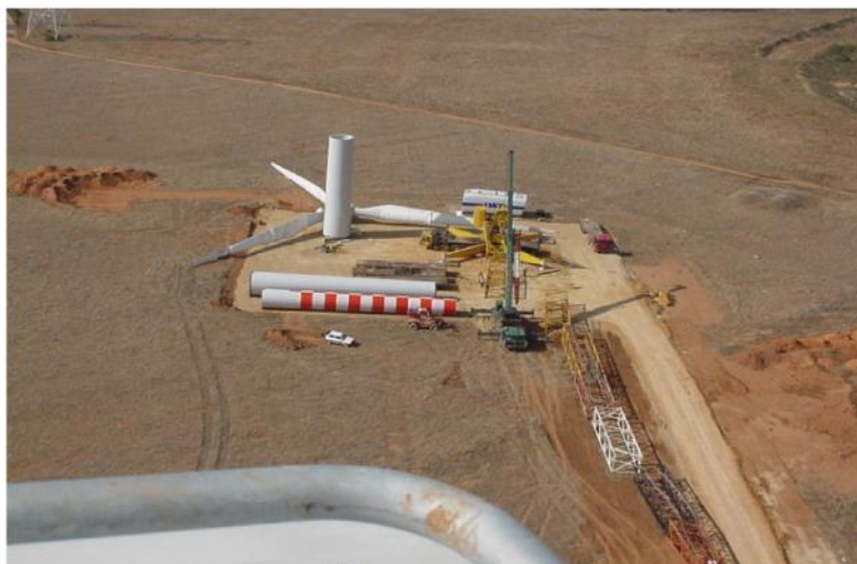
Figura 49 – Piazzola per il montaggio dell'aerogeneratore
