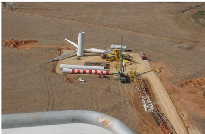
Figura 27 – Piazzola per il montaggio dell'aerogeneratore
