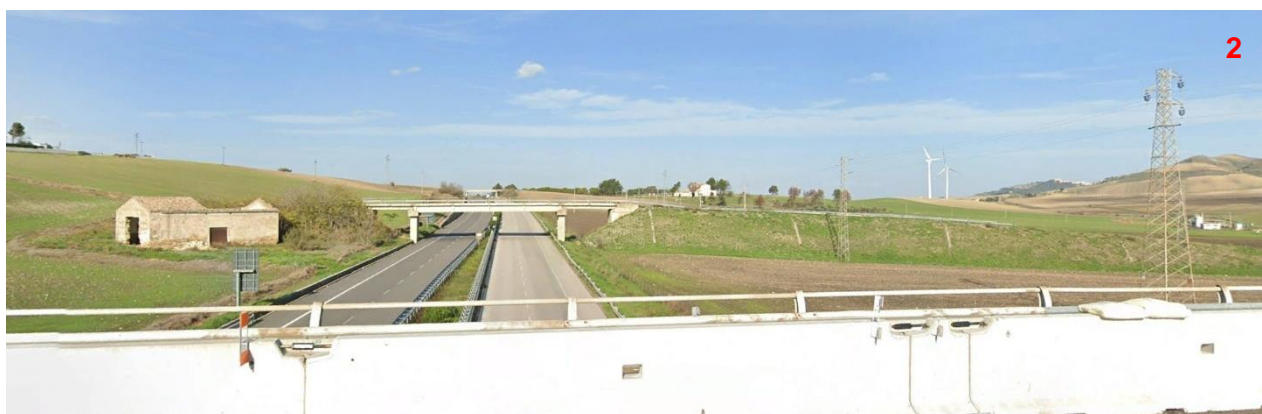
Figura 7-55. Riprese fotografiche dal cavalcavia sopra la SS655 dell'Autostrada A16
