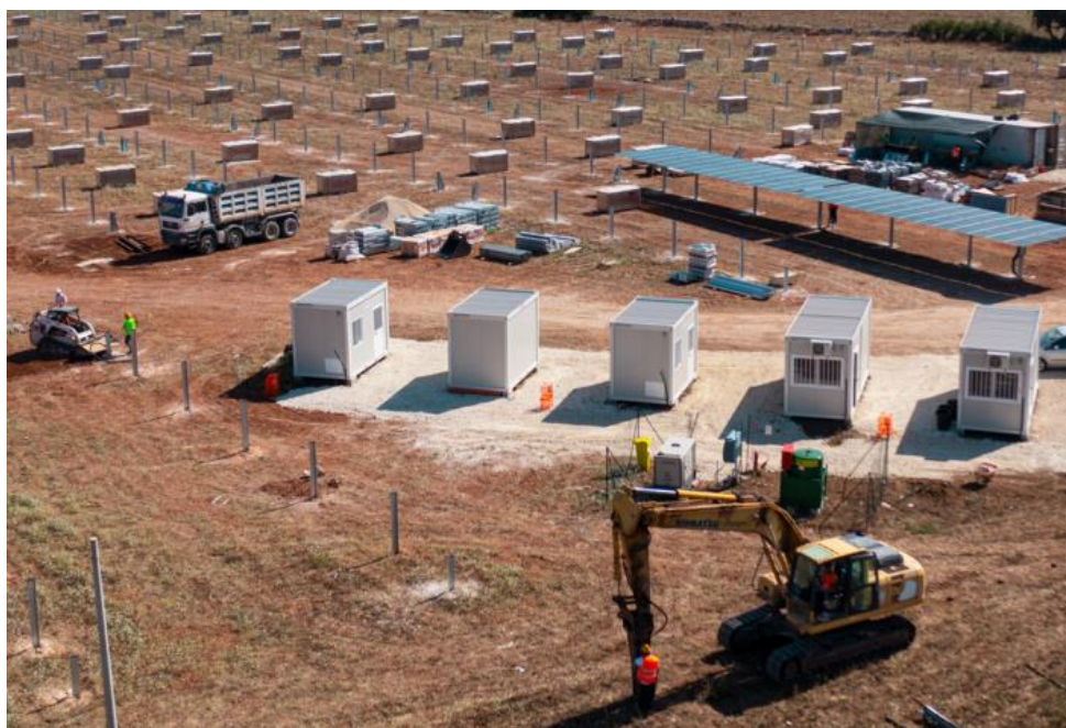
Figura 7-50. Esempio di cantierizzazione di impianto agrivoltaico (dal web)
