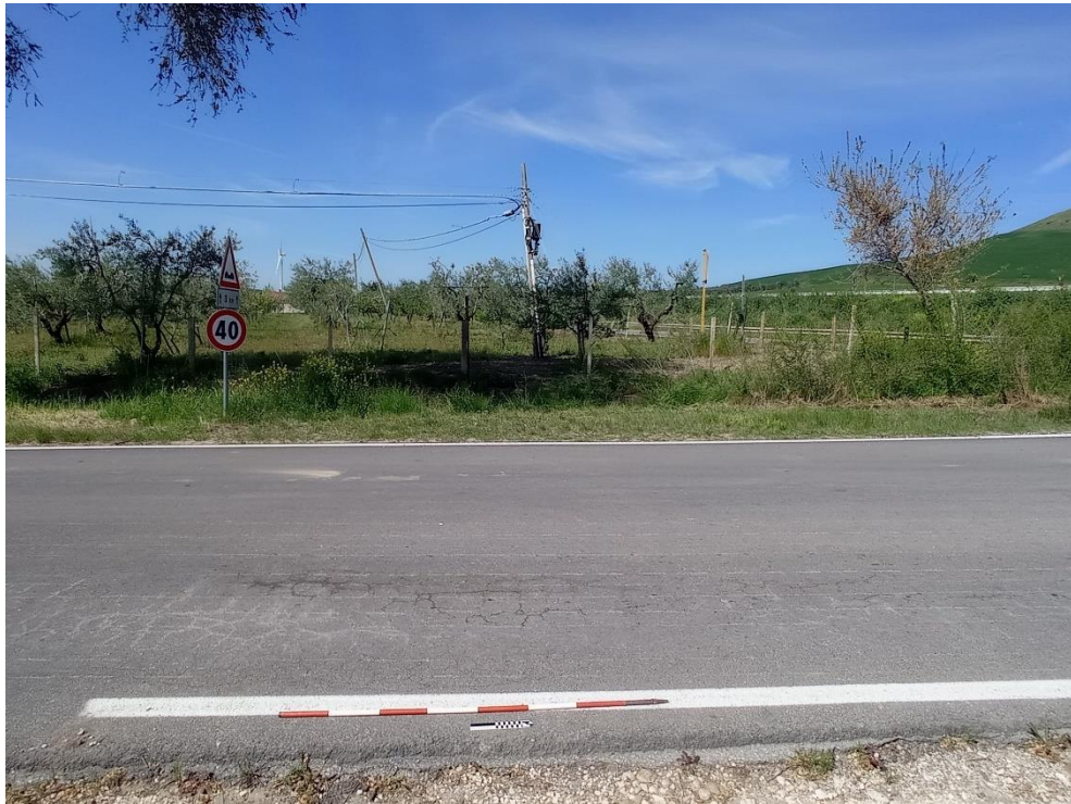
Figura 63-35: UR 28, vista da E.
