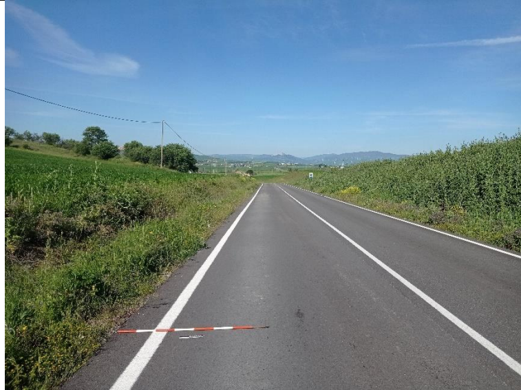
Figura 74-46: UR 36, settore centrale, vista da E.
