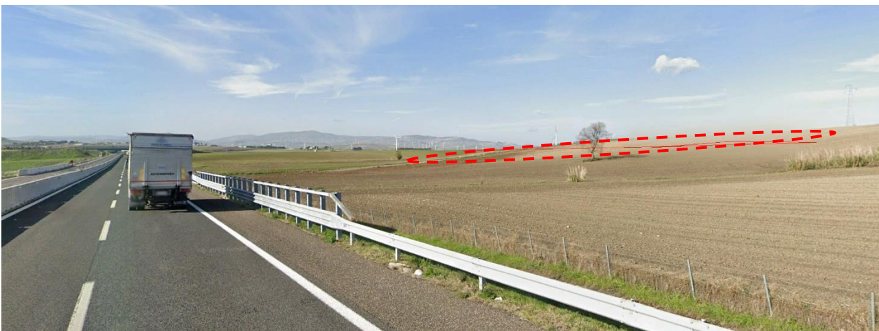
Figura 3–35. Vista dalla E842 Napoli – Canosa (in rosso: area d'intervento)
