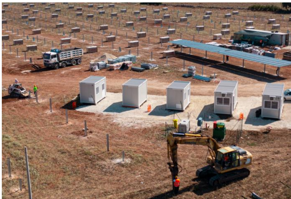
Figura 6–1. Esempio di cantierizzazione di impianto agrivoltaico (dal web)
