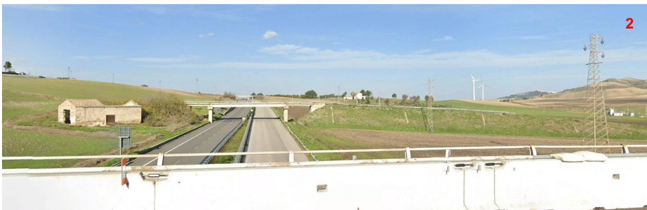
Figura 6–6. Riprese fotografiche dal cavalcavia sopra la SS655 dell'Autostrada A16
