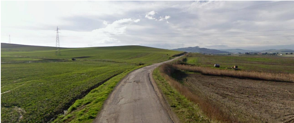
Figura 3–38. Vista verso l'impianto (dietro il rilievo) dalla Masseria Monti Carpinelli (Azienda Agricola Potito Gallo)
