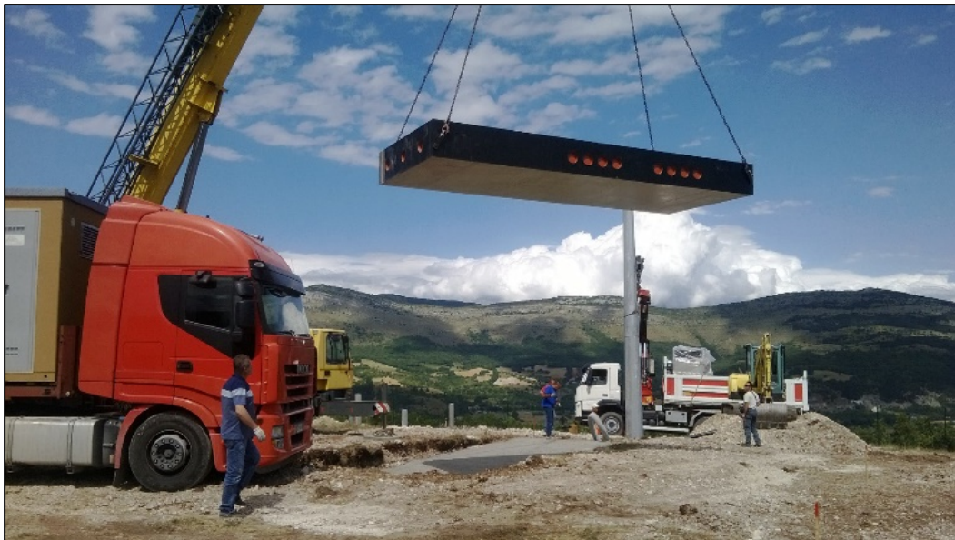
Figura 12 - Messa in opere vasca di fondazione
