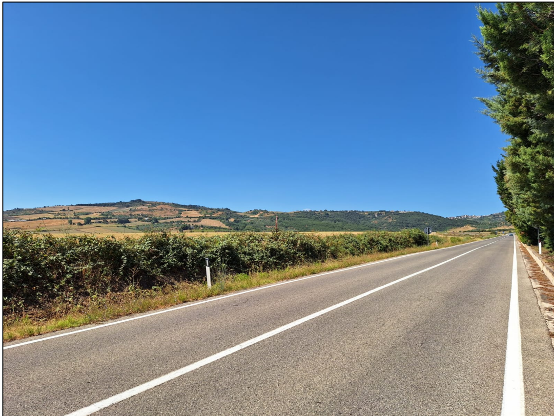
Figura 10 - Rilievo fotografico SP 169
