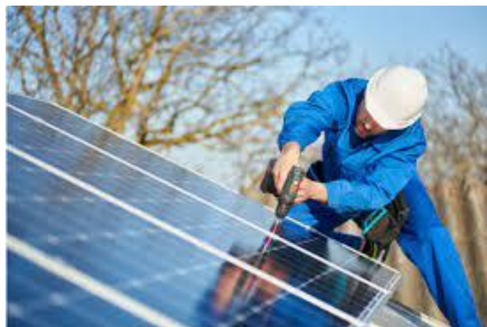
Figura 31: Fissaggio dei moduli fotovoltaici
