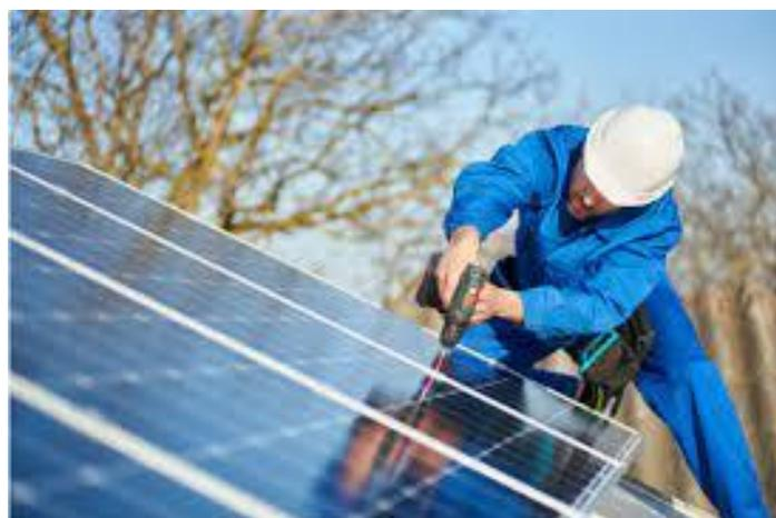
Figura 4: Fissaggio dei moduli fotovoltaici
