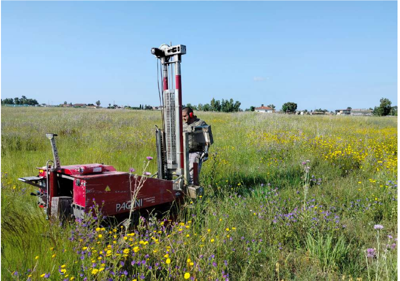
Foto 5- Esecuzione DPSH n.5
