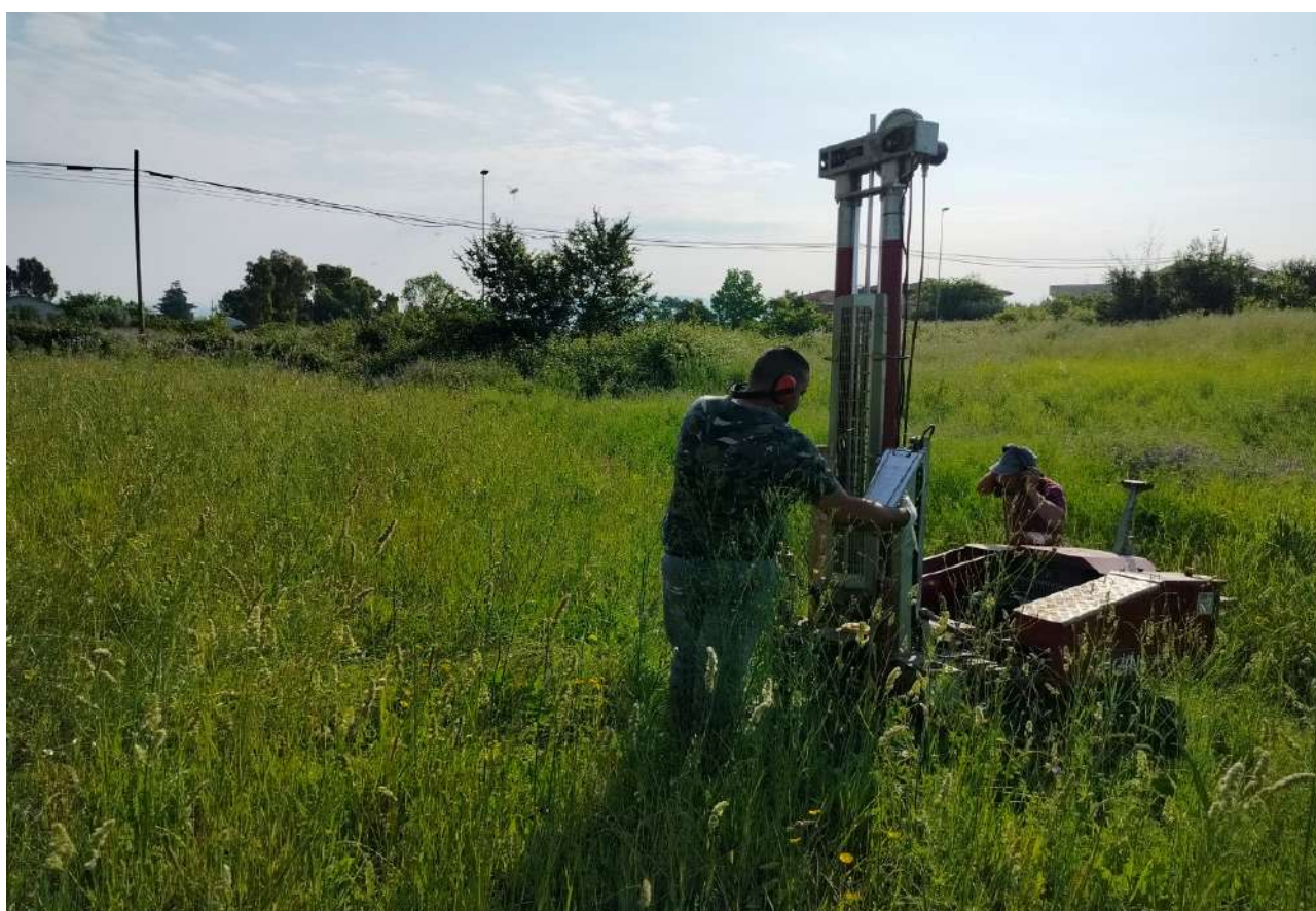
Foto 2- Esecuzione DPSH n.2
