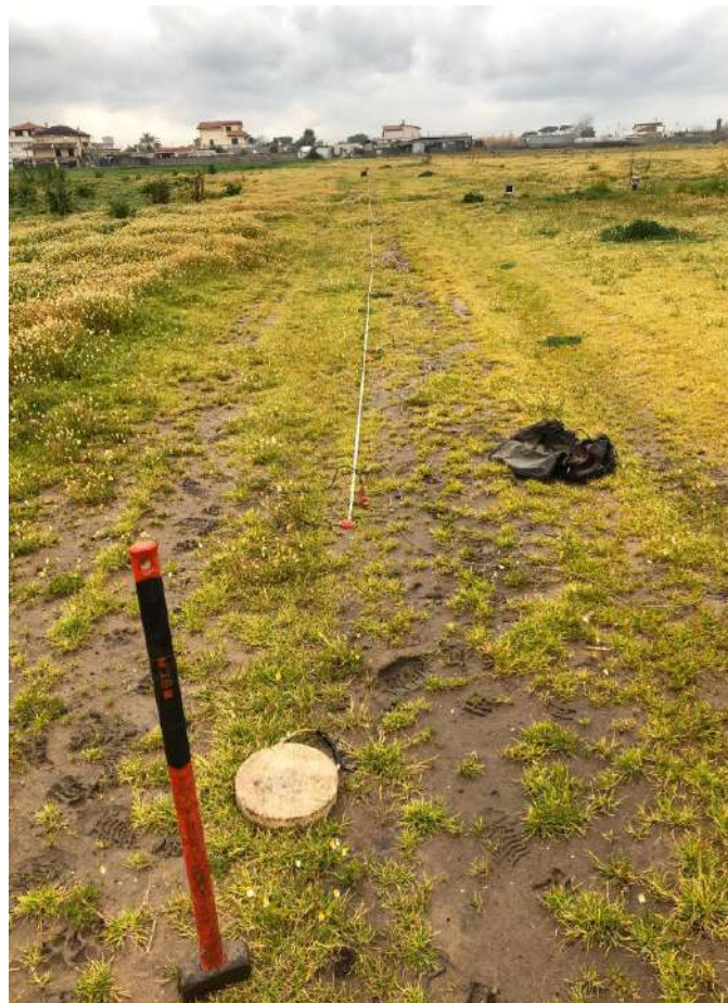
Fig. 26 - Foto della preparazione della prospezione sismica Masw
