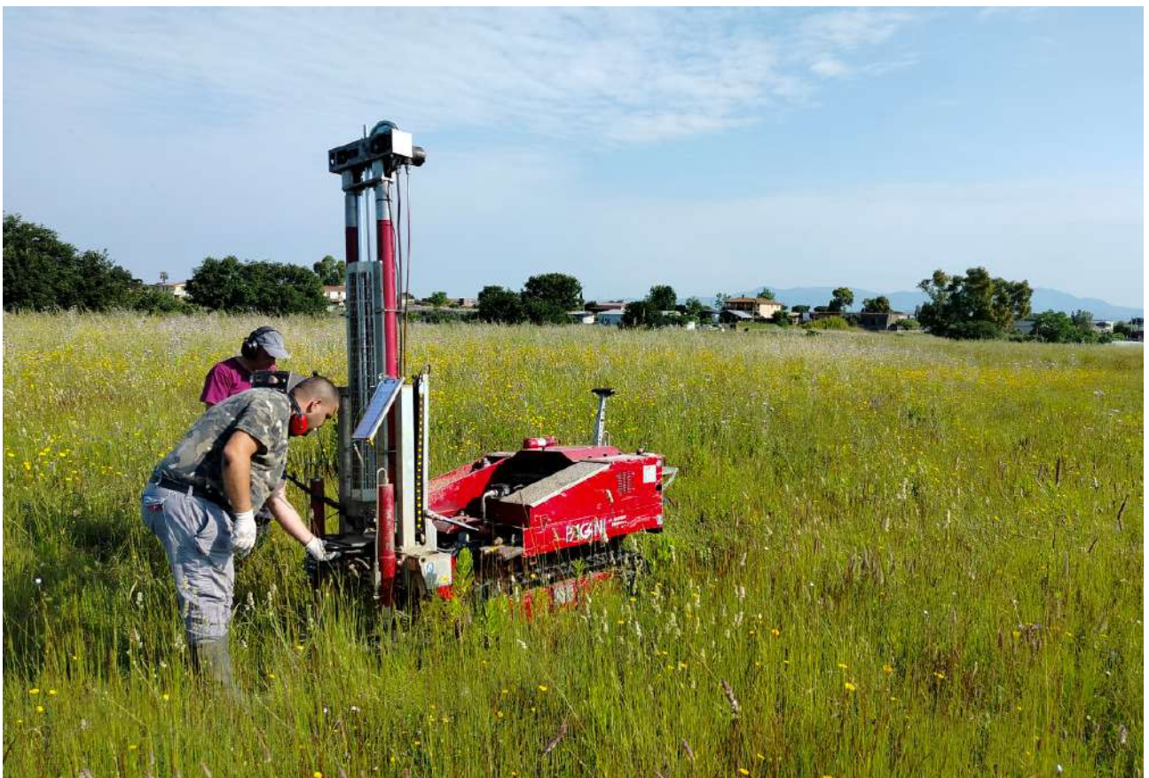
Foto 4- Esecuzione DPSH n.4
