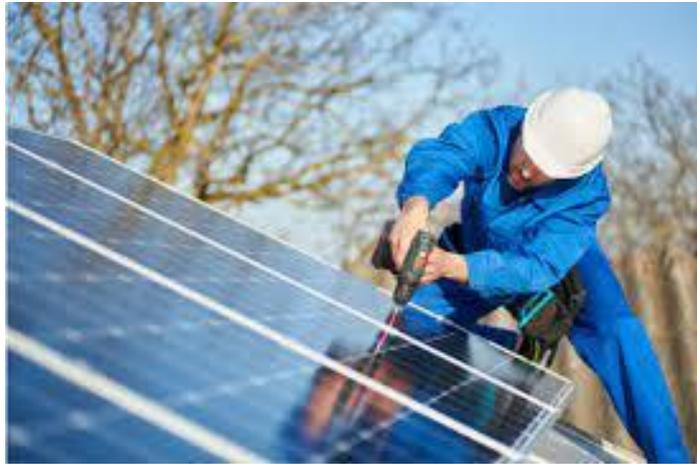
Figura 9: Fissaggio dei moduli fotovoltaici
