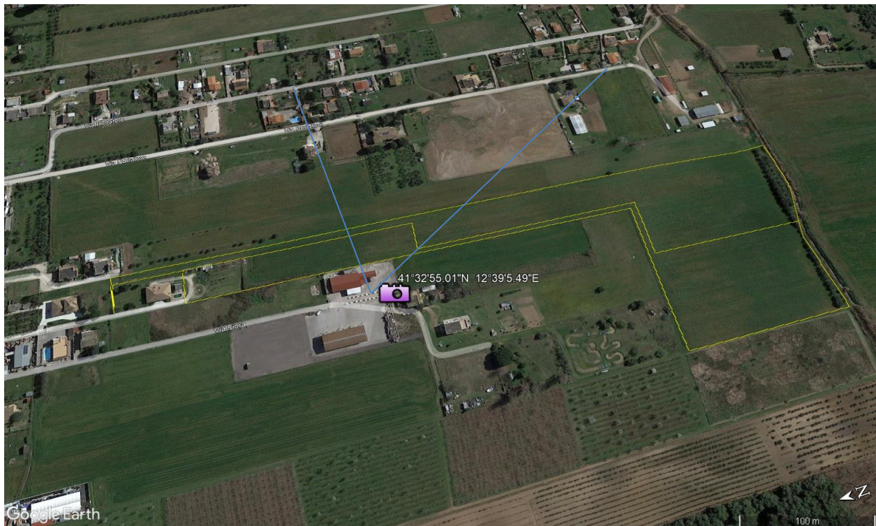
Figura 30: Stato di fatto dei lotti di terreno destinati alla costruzione del Sottocampo 5 e ubicazione del punto di presa fotografica
