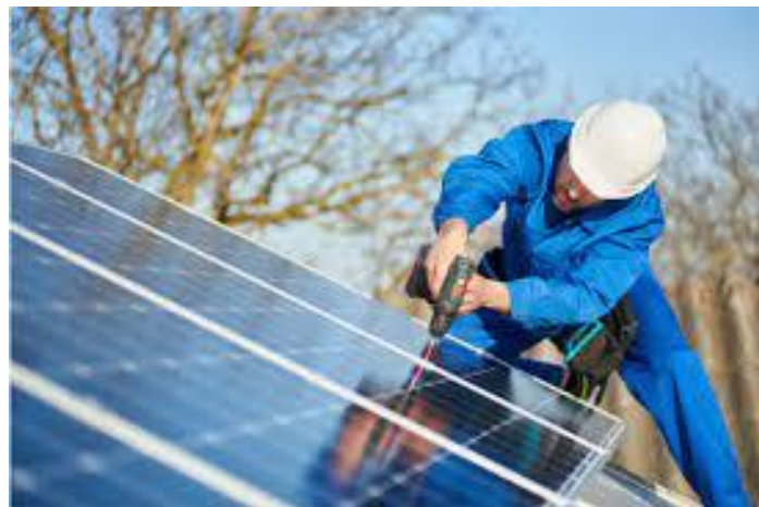
Figura 9: Fissaggio dei moduli fotovoltaici
