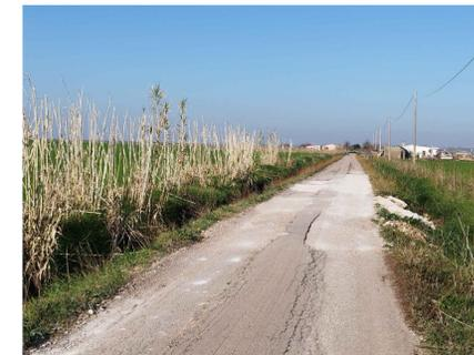
TIPOLOGIA 2: Viabilità esistente con pavimentazione naturale in pessimo stato
