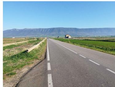
TIPOLOGIA 12: Viabilità esistente in conglomerato bituminoso in pessimo stato
