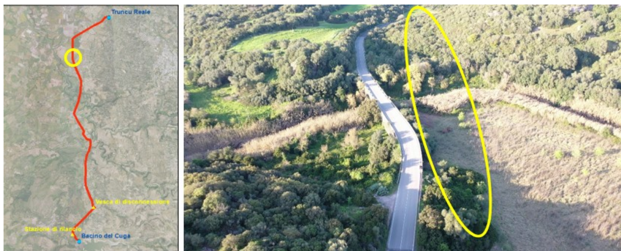
Figura 18 – Percorso acquedotto in prossimità del Rio Mannu
