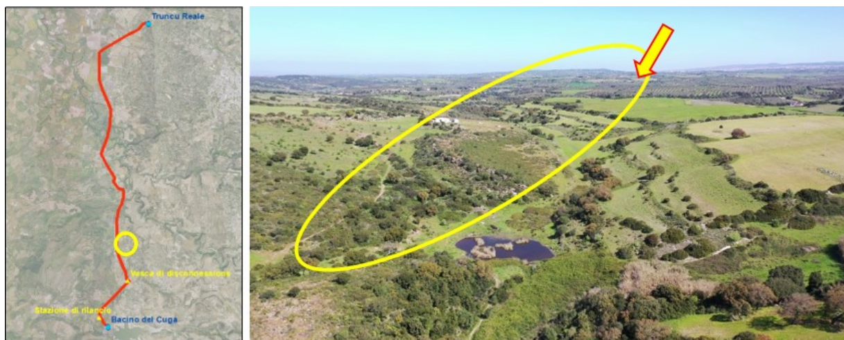
Figura 10 – Percorso acquedotto in prossimità della vasca di disconnessione. La freccia indica, indicativamente il punto di posizionamento della vasca.
