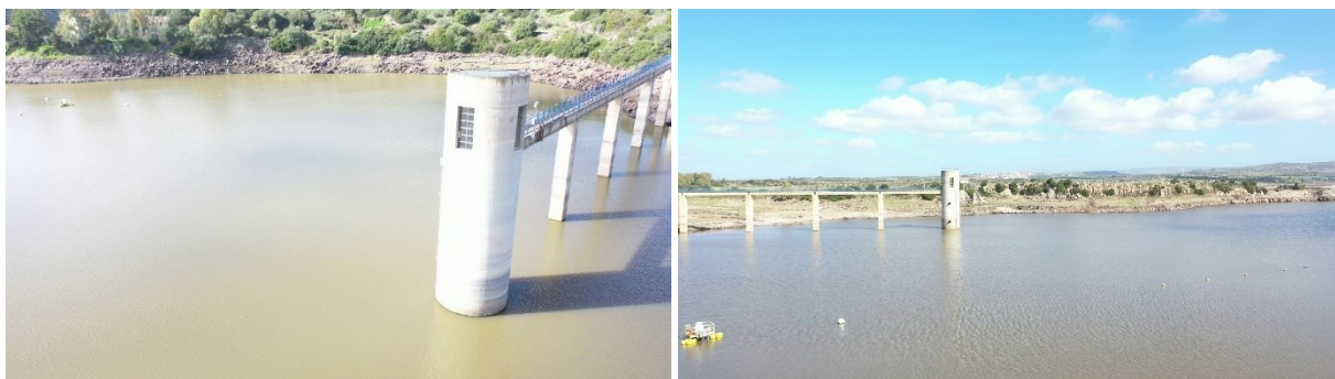
Figura 5 – Lago del Cuga - opera di presa esistente (non oggetto di intervento)
