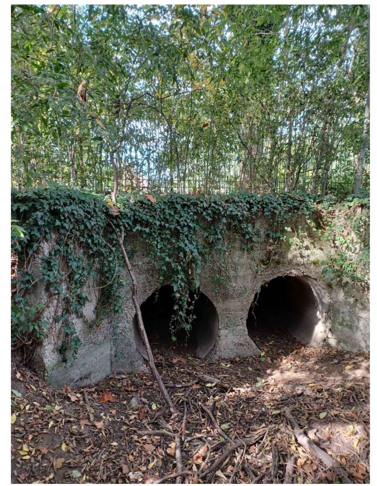
FOTO 1 - TUBAZIONI ESISTENTI - 2xDN900
