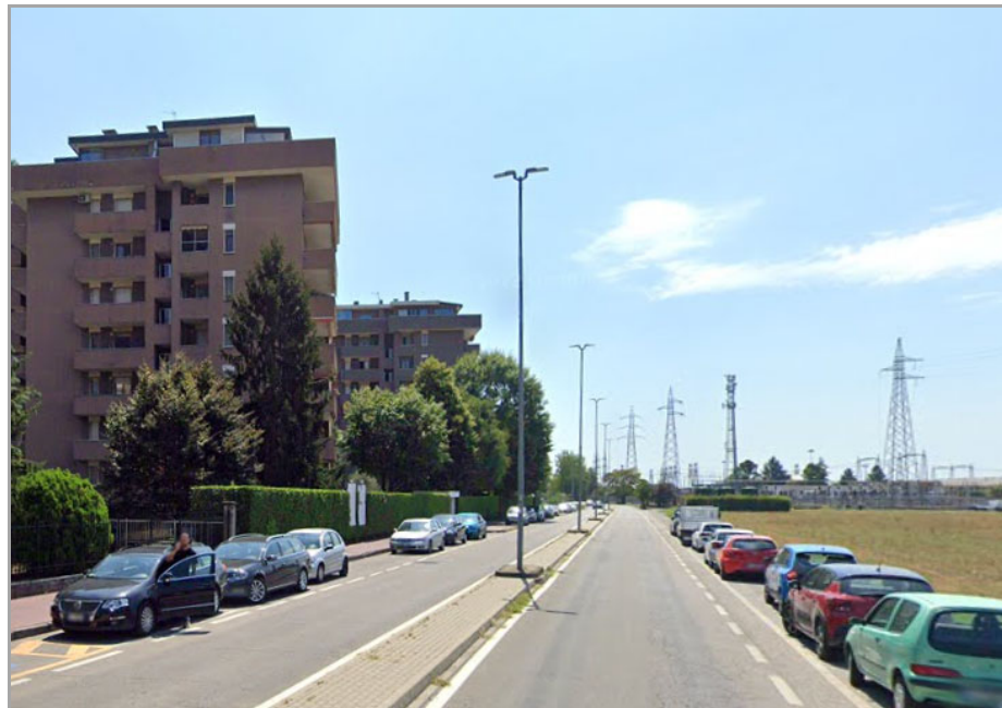
Figura 5.8 Tratto intermedio di via Edison; a destra sullo sfondo la Cabina Primaria Enel e la Stazione Elettrica Terna con gli elettrodotti che le raggiungono
