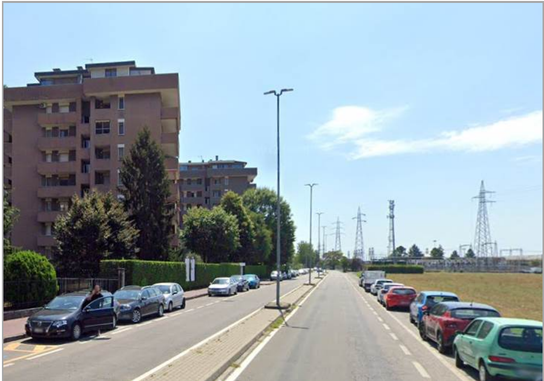
Figura 6.5.3 Tratto intermedio di via Edison; a destra sullo sfondo la Cabina Primaria Enel e la Stazione Elettrica Terna con gli elettrodotti che le raggiungono
