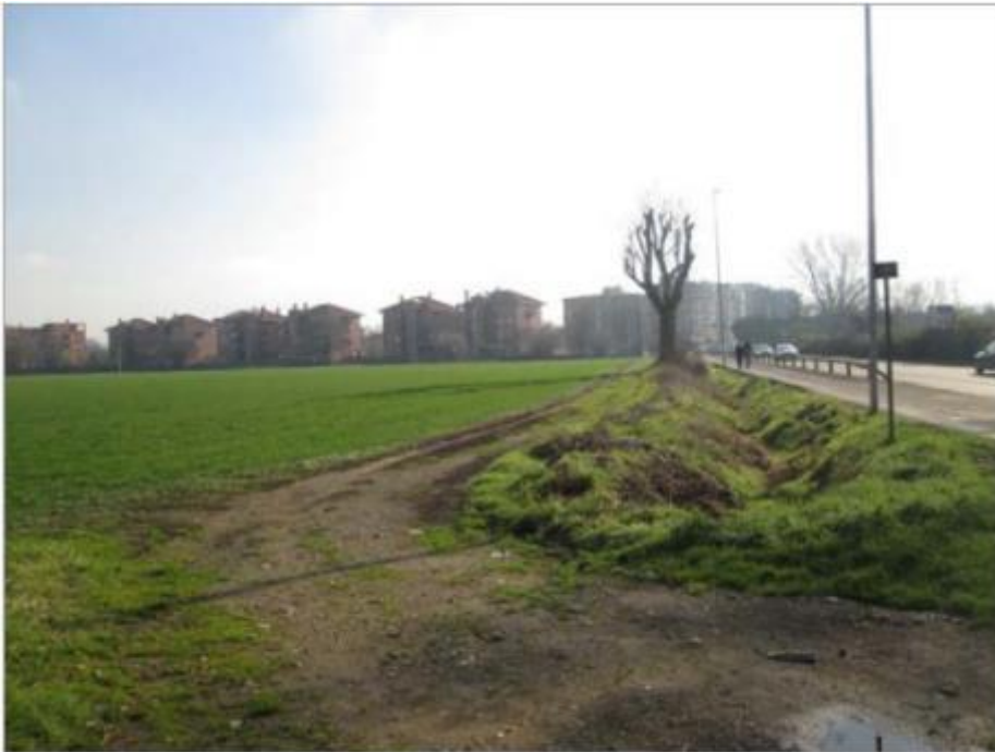
Figura 4-65: Transizione tra l'unità di paesaggio delle zone agricole e quella del paesaggio urbano
