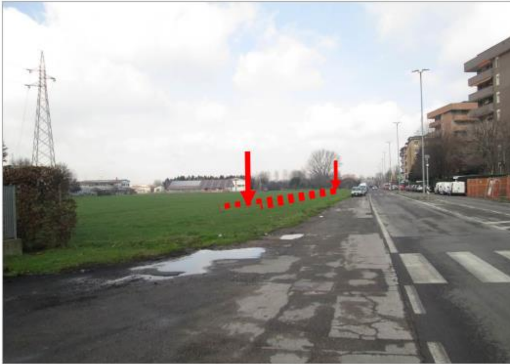
Figura 5-15: Vista d'insieme del tratto in affiancamento di via Edison, tra l'uscita della TOC n. 5 e l'ingresso della TOC n. 6, vista sud
