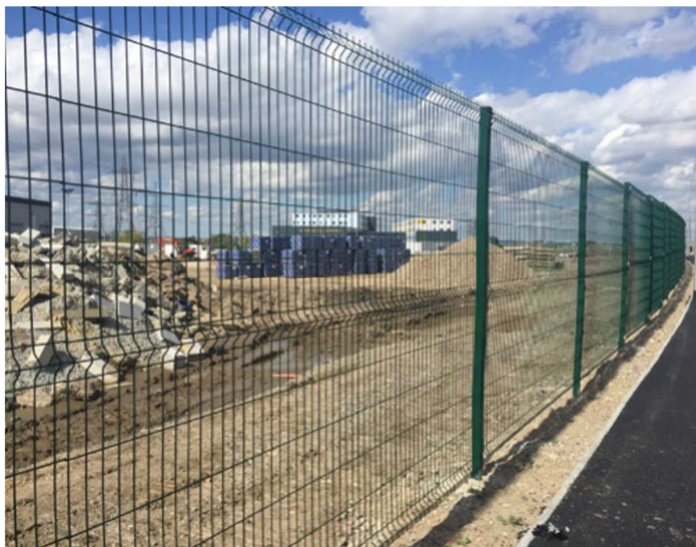
Figura 8-6: Esempio di recinzione di cantiere
