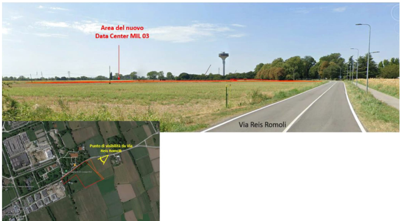
Figura 9-8: Punto di possibile visibilità del Data Center MIL 03 da est, lungo via Reiss Romoli
