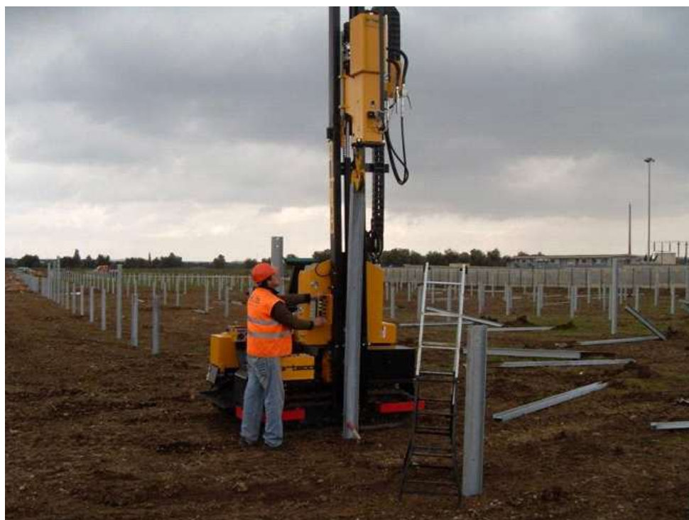
Figura 6 – Macchina battipalo in azione
