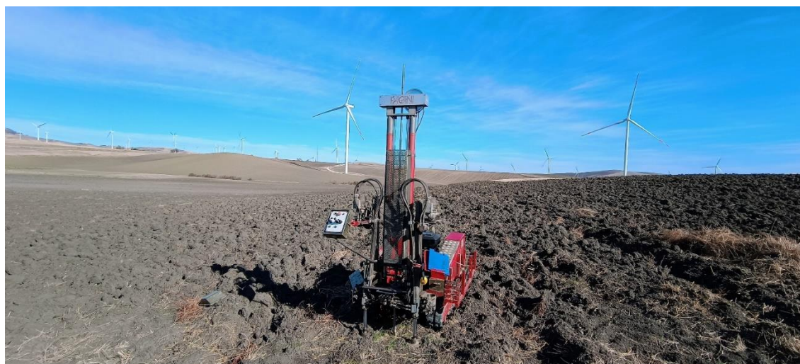
Figura 10 - Esecuzione della Prova penetrometrica DPSH 3
