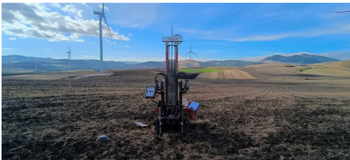
Figura 7 Esecuzione della Prova penetrometrica DPSH 2
