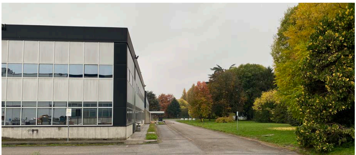
Figura 6-22 | Presenza di vegetazione all'interno del sito ex Italtel prima dell'avio delle demolizioni degli edifici esistenti.
