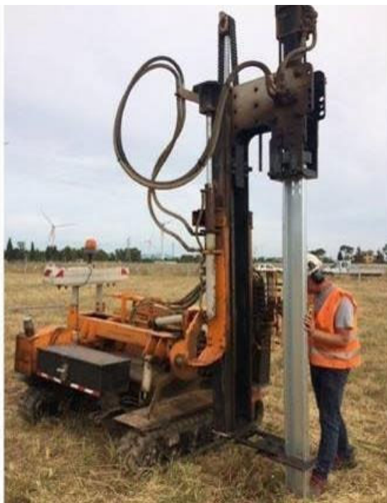
Fig. 51 _ Esempio di supporto costituito da palo in acciaio infisso direttamente nel terreno mediante battipalo
