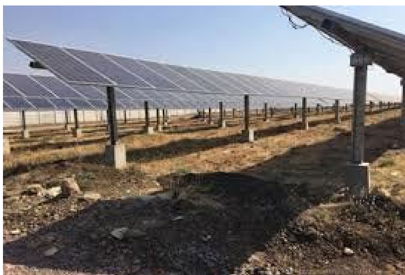
Fig.52 _ Esempio di impianto fotovoltaico con fondazioni ottenute mediante perforazione del terreno e successiva creazione del palo di fondazione con getto di cemento
