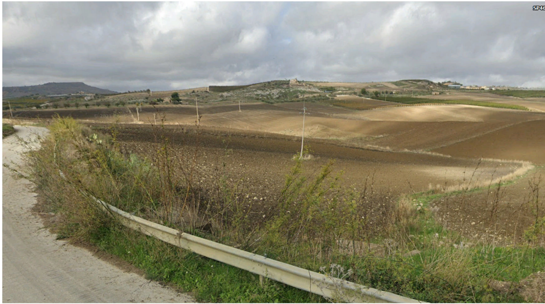
Fig.23_ Macroarea_zona Sud dell'impianto fotovoltaico
