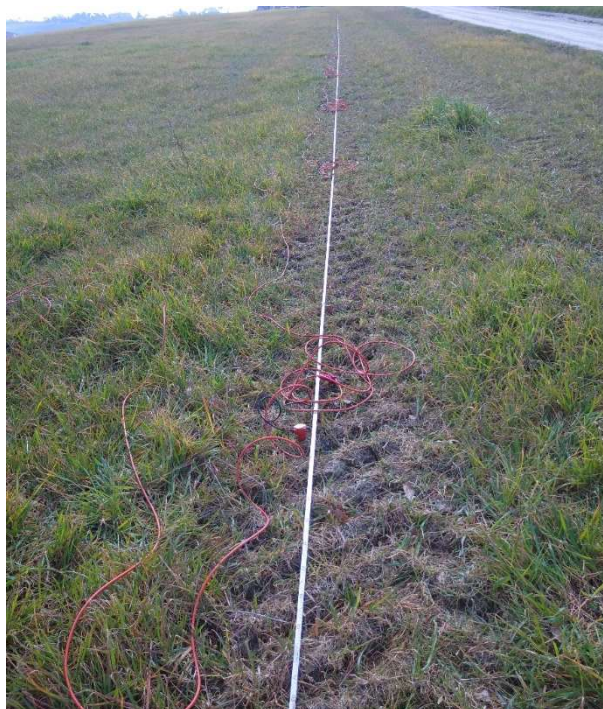
Foto 2 - Particolare esecuzione indagine sismica
