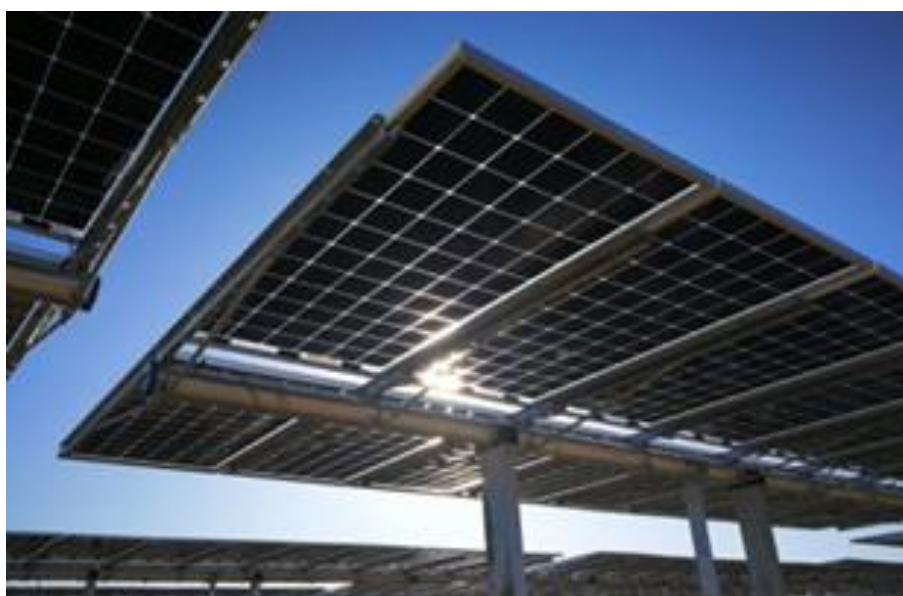
Figura 4.3: Esempio di struttura a tracker monoassiale 2p.
