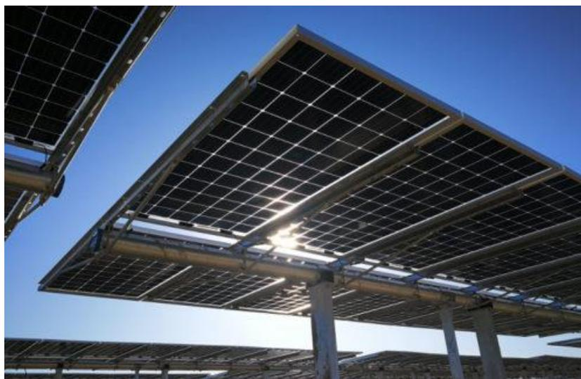
Figura 3.2: Esempio di struttura a tracker monoassiale.
