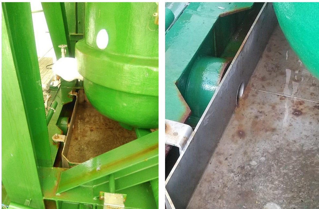
Figura 4-2: bacino di contenimento GNL in corrispondenza delle pompe booster; si nota la presenza di ghiaccio su tubazione e acqua di condensa
