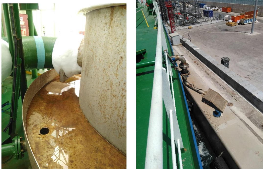
Figura 4-3: figura a sinistra: bacino di contenimento GNL in corrispondenza Recondenser e scarico di fondo; si nota la presenza di ghiaccio su tubazione e la formazione di acqua di condensa. Figura a destra: punto di scarico emergenza GNL e acqua di condensa.
