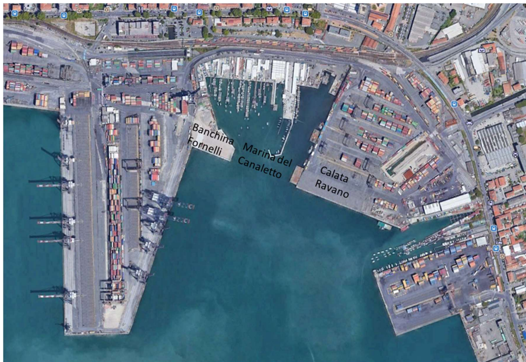
Figura 2.1. Vista dell'area di intervento allo stato attuale
